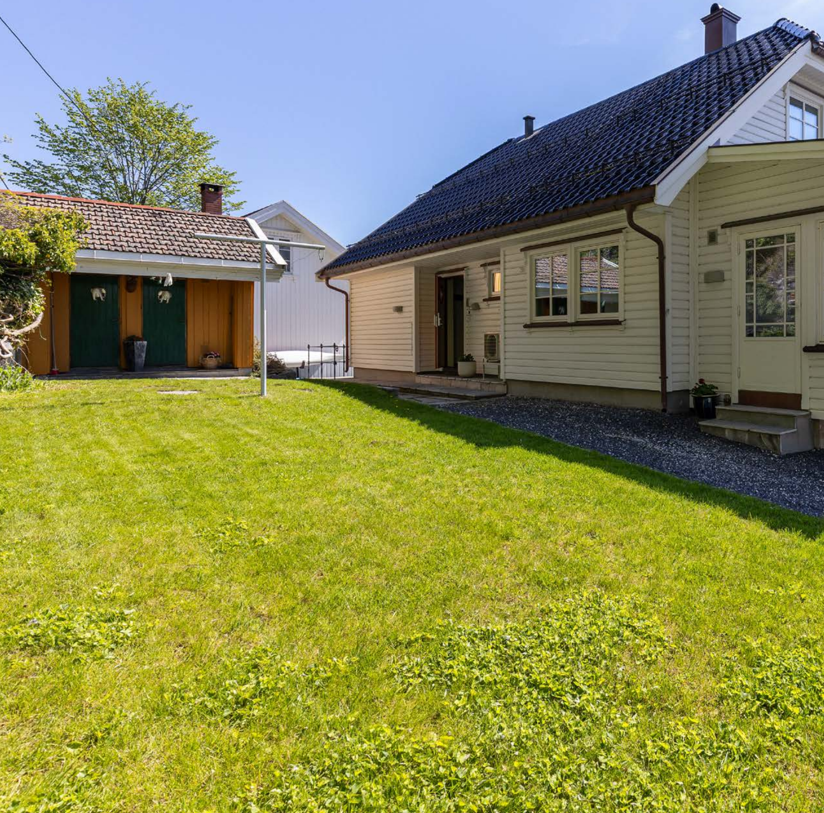
Ved huset er det vedbod/kjølerom som er oppført rundt 1988.
