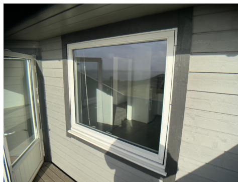
Vindu på kjøkken datert 2014
