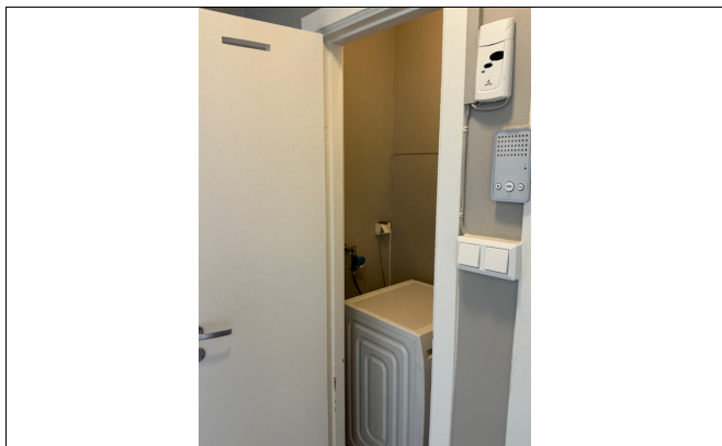
Kott med opplegg for vaskemaskin, waterguard.
