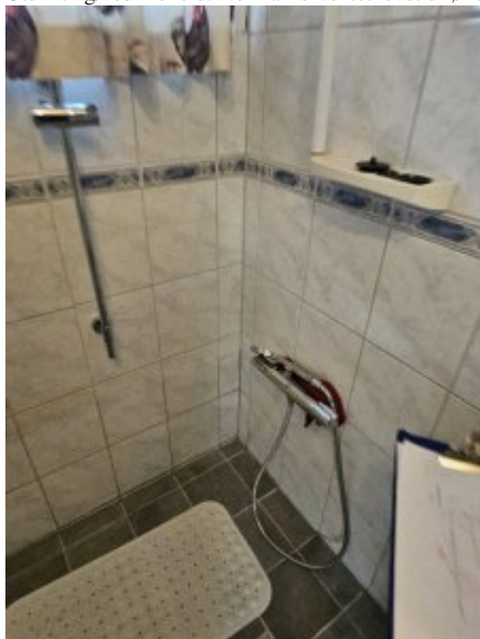
TG 2 7.1.2 Overflate gulv
