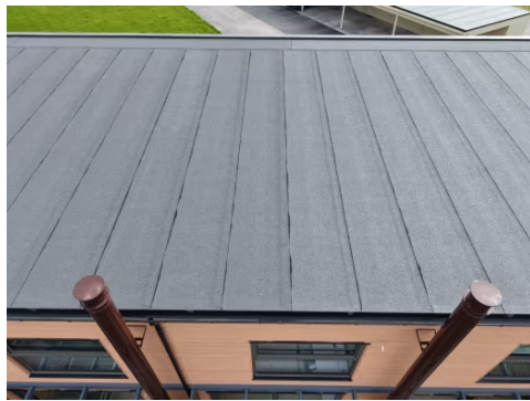
Yttertaket er tekket med asfaltpapp.
