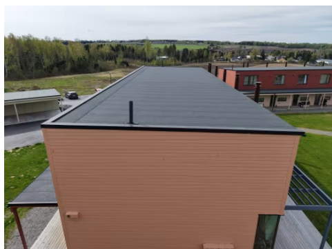
Rekkehuset er oppført med pulttakskonstruksjon.
