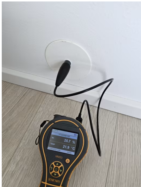
Bilde fra fuktmåling i veggkonstruksjon tilstøtende dusjsone.
