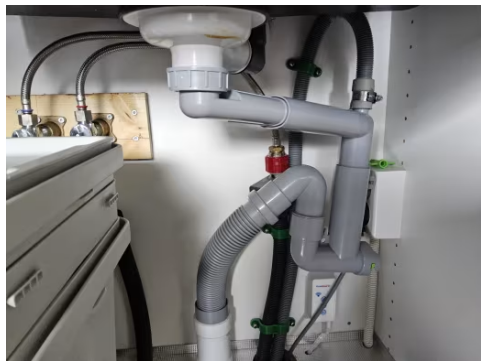
Synlige avløpsrør av plast i boligen.
