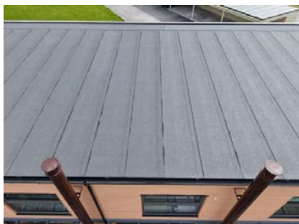
Yttertaket er teknet med asfaltpapp.
