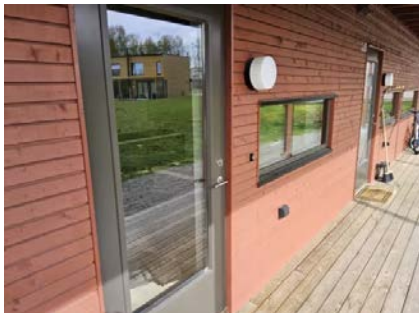
Boligen er utvendig kledd med liggende trekledning.
