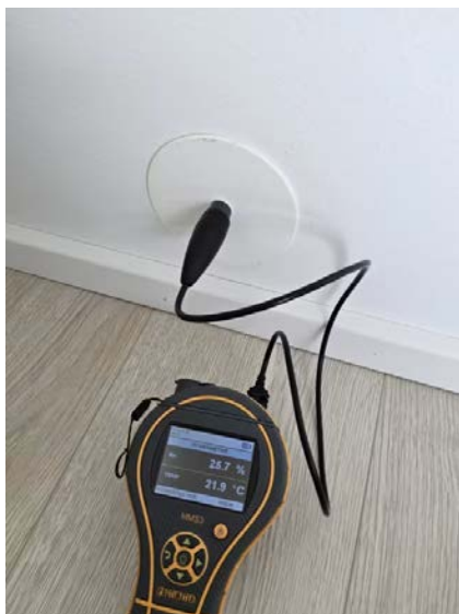
Bilde fra fuktmåling i veggkonstruksjon tilstøtende dusjsone.
