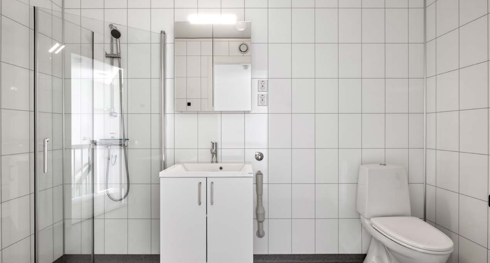
Lyst og pent bad med belegg på gulvet med varmekabler. På veggene er det baderomsplater.
