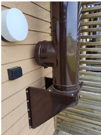
Bilde av utvendig stålppe.
