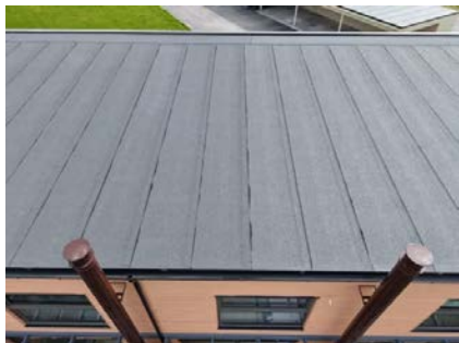
Yttertaket er tekket med asfaltpapp.
