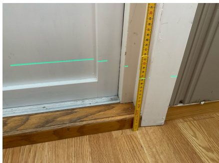
Måling på stue. 30mm skjevhet.
