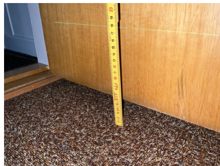
Måling i gang, 35mm skjevhet.
