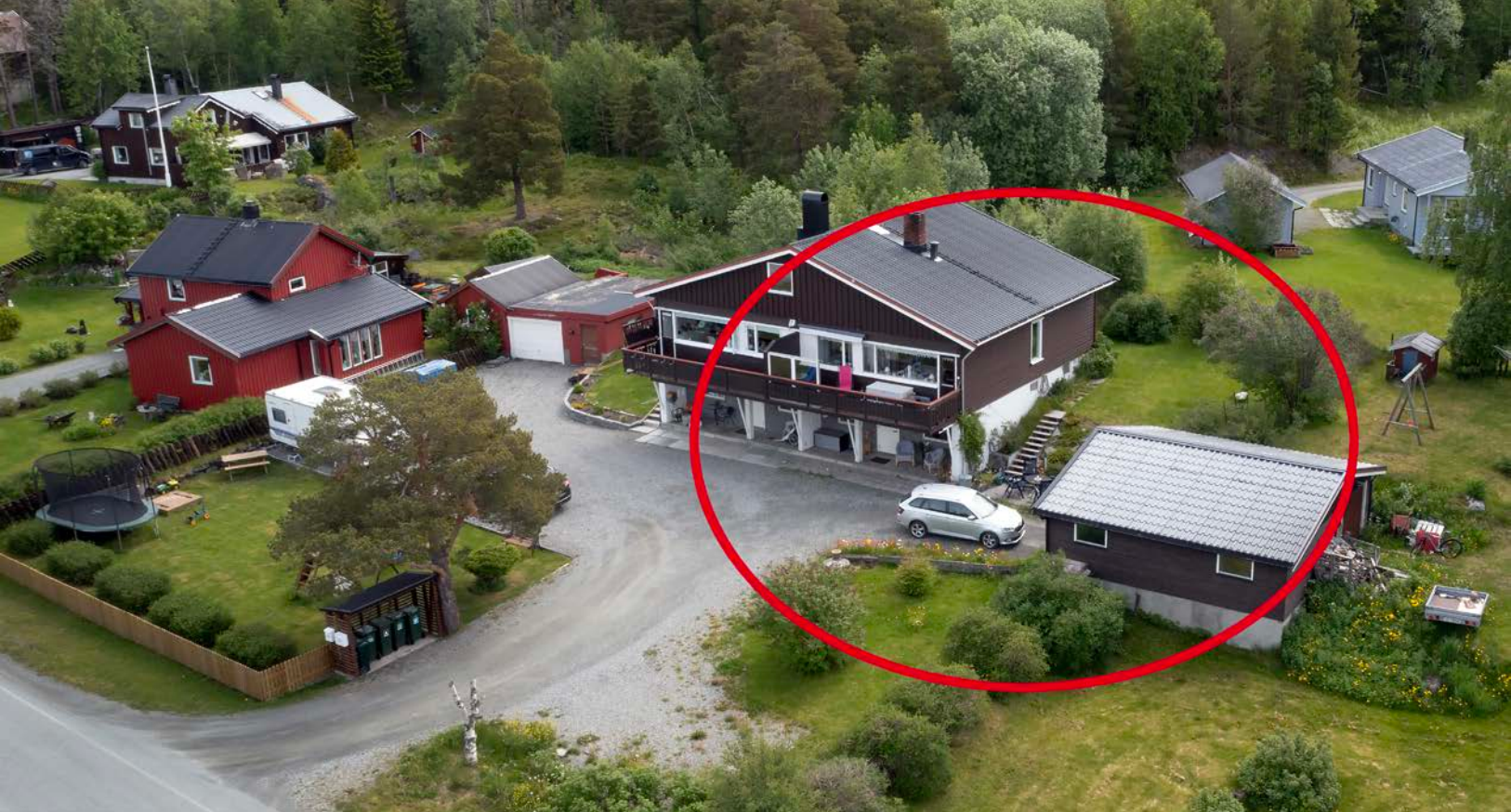
Fasade med markering
