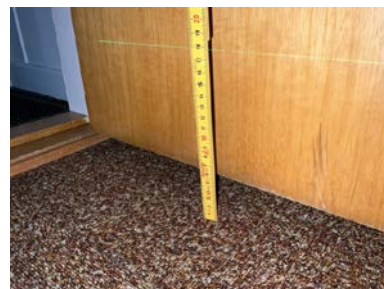
Måling i gang. 35mm skjevhet.
