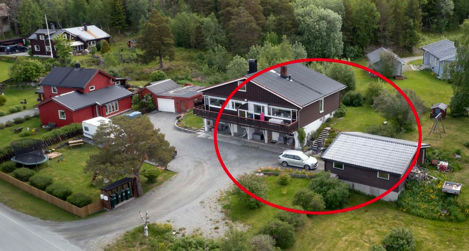
Fasade med markering
