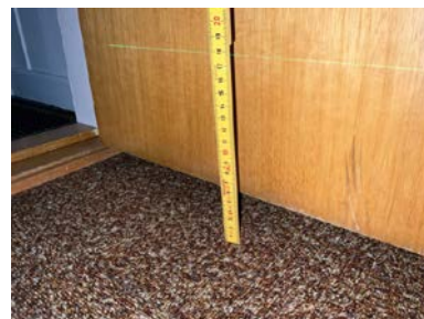
Måling i gang. 35mm skjevhet.
