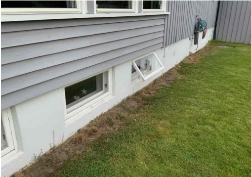
Kontroll av drenering/fuktsikring.
