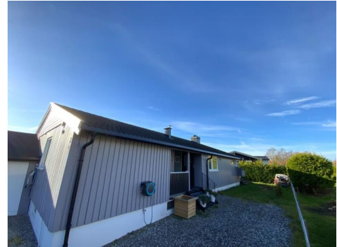
Besiktigelse av taktekke.
