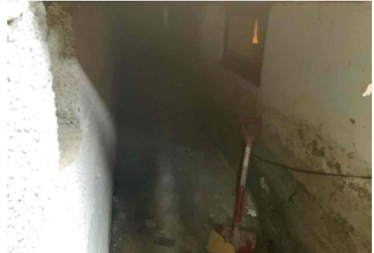
Kontroll av kryprom.
