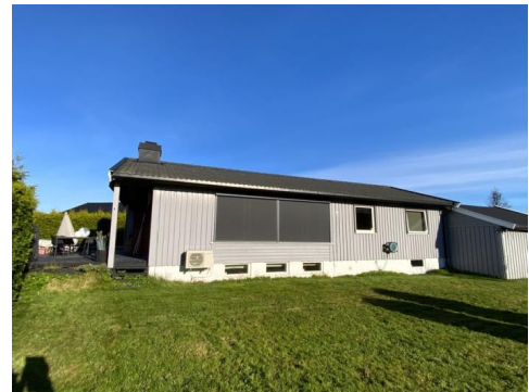
Besiktigelse av taktekke.
