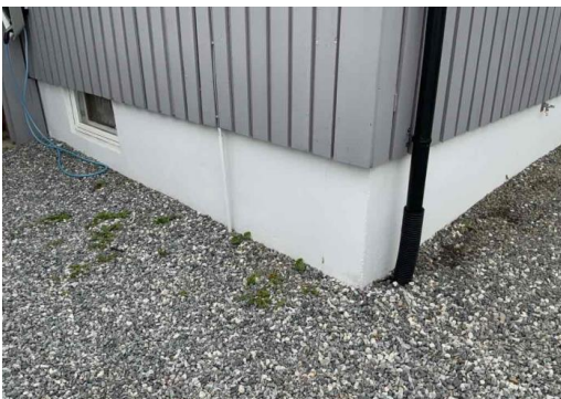
Kontroll av drenering/fuktsikring.
