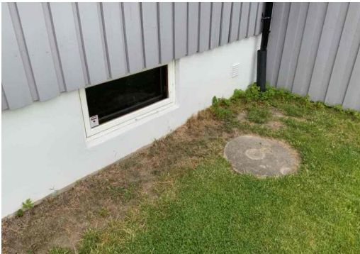
Kontroll av drenering/fuktsikring.
