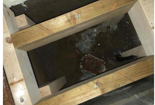
Stakepunkt på avløpsrør.
