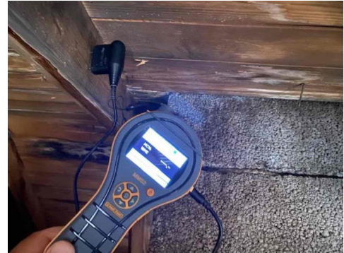
Ingen høy fuktprosent ble målt på befaringsdagen.
