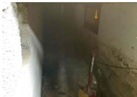
Kontroll av kryprom.
