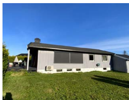
Besiktigelse av taktekke.
