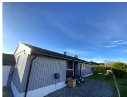
Besiktigelse av taktekke.
