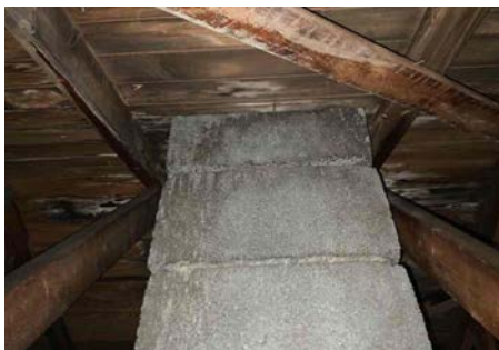
Kontroll rundt pipeløp.
