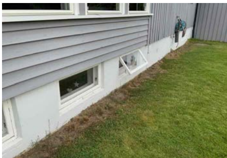
Kontroll av drenering/fuktsikring.
