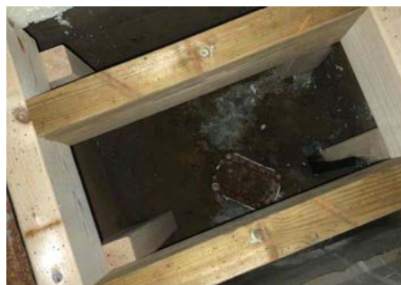
Stakepunkt på avløpsrør.
