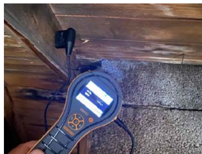
Ingen høy fuktprosent ble målt på befaringsdagen.
