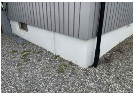
Kontroll av drenering/fuktsikring.
