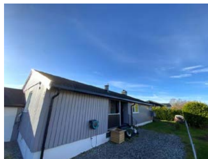
Besiktigelse av taktekke.
