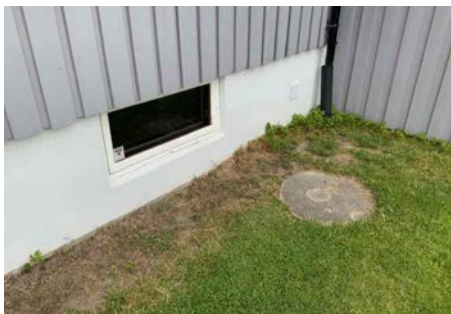
Kontroll av drenering/fuktsikring.
