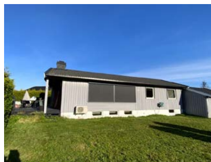
Besiktigelse av taktekke.
