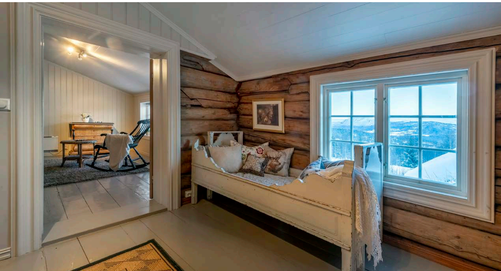
Størstedelen av bygget er kledd på innsiden, men i 2. etasjen har en latt deler av tømmeret være synlig
