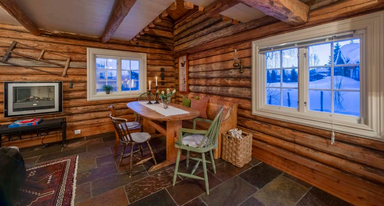
Gulvet har skiferflis med undervarme
