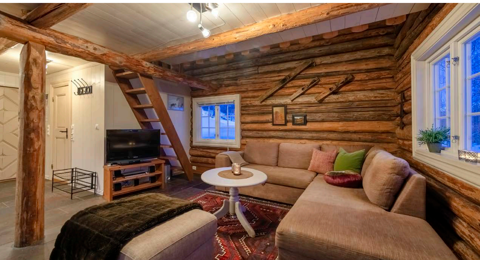
Bygningen er oppført i rundtømmer fra ca. 1870 som er grundig rengjort og tettet under oppføring
