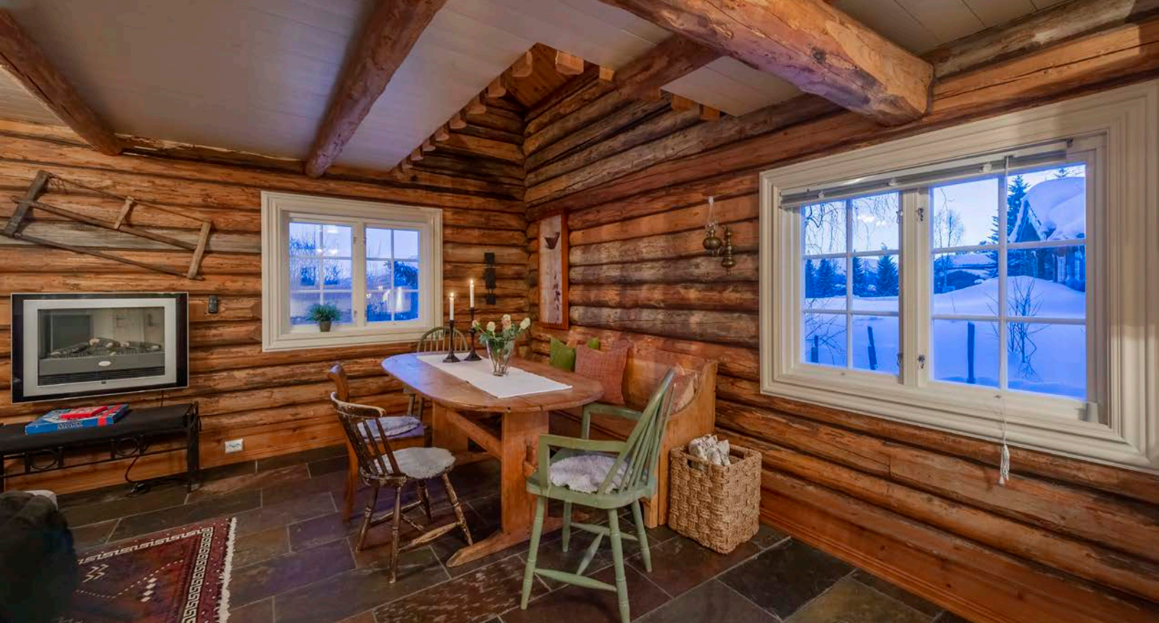
Gulvet har skiferflis med undervarme
