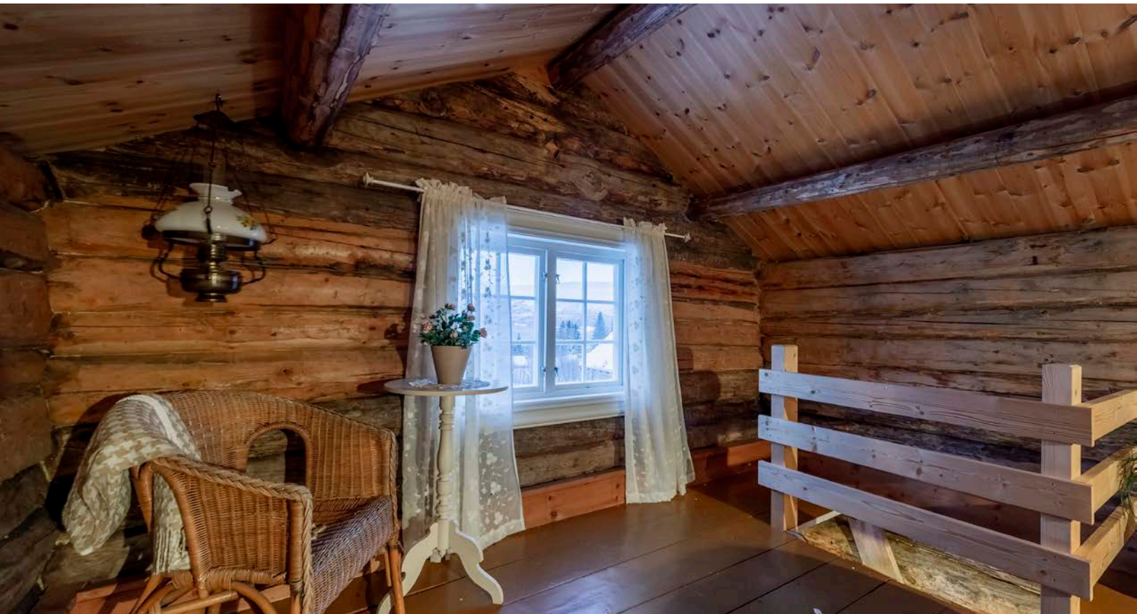
I loftsetasjen er ytterveggene forhøyet med nyere tømmer for å øke takhøyden Ekte håndverk!
