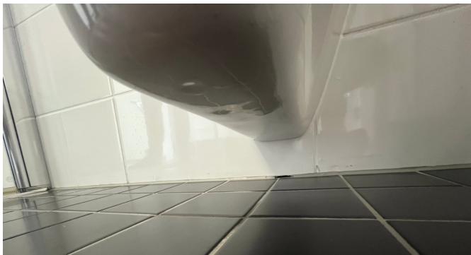
Lekkasjesikring av vegghengt toalett.
