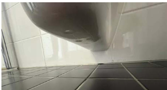
Lekkasjesikring av vegghengt toalett.
