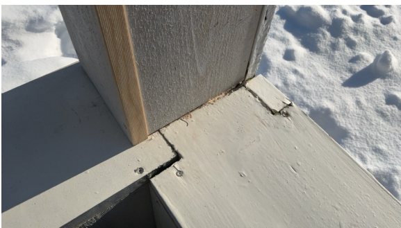
Eksempel på sprekk i toppbord.
