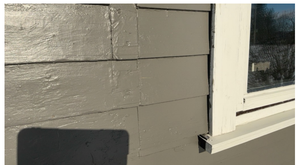
Eksempel på kledning som er skjøtet inn.
