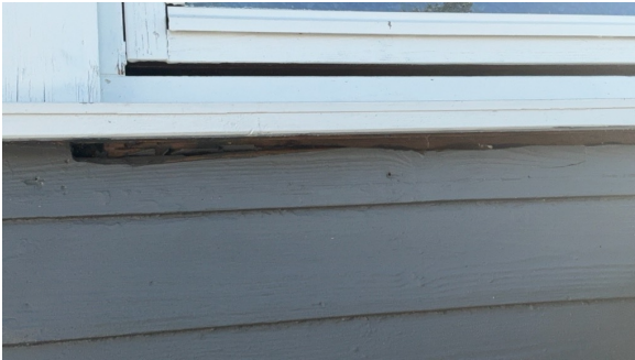
Eksempel på grov avslutning under vindu.
