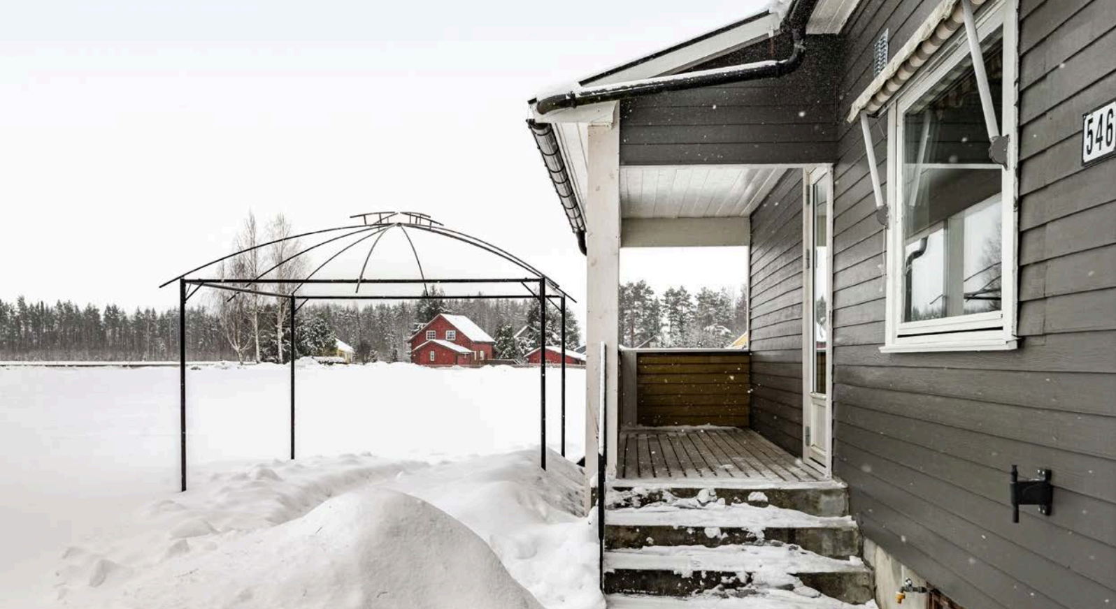
Overbygget veranda med på pilarer av betong og med betongtrapp.
