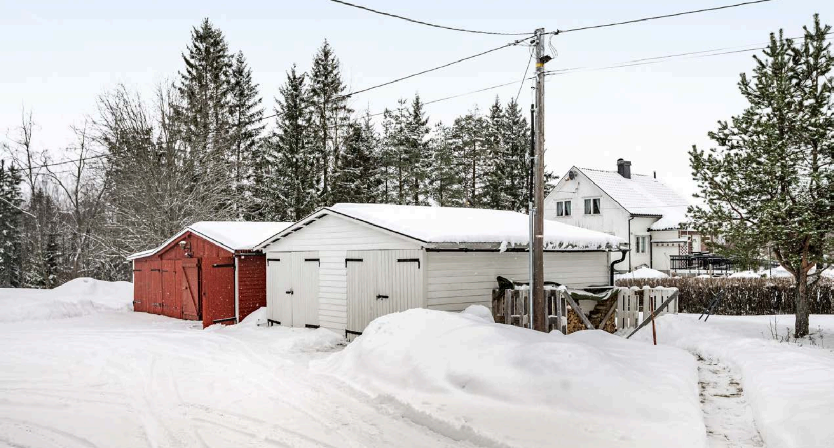
Garasjen er bygd i 1985. Fundamentert med punktfundamenter og støpt plate, og har vegger av reisverk med liggende trepanel.
