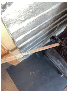
Avstand til brennbart under 30 cm
