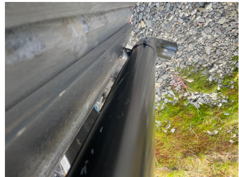
Frostsprenget nedløp
