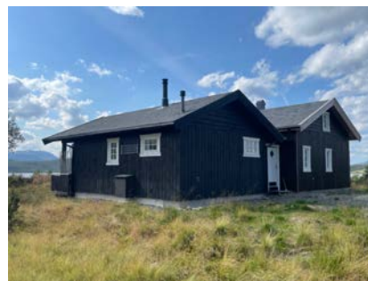
Manglende takstige til begge piper.
