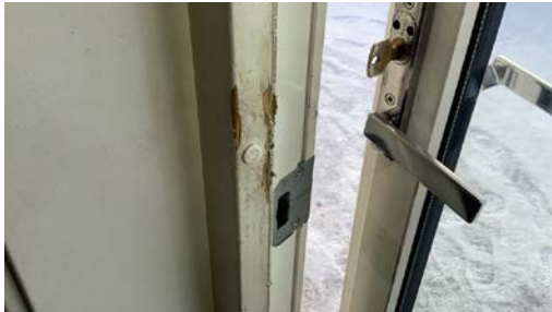
Skade på karm og tettelist.
