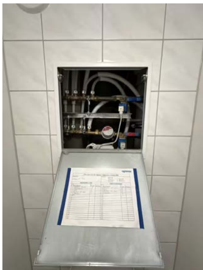
Vannrør med rør i rør system fra åpen fordeler plassert i sjakt på toalettrom og frem til sanitærinstallasjoner på toalettrom, baderom og kjøkken.
