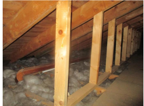
Deler av takkonstruksjonen.
