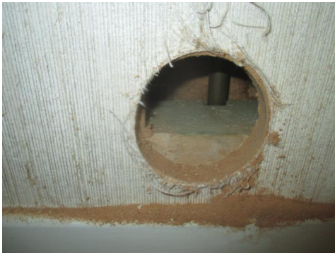
Hulltaking i fra soverom.
