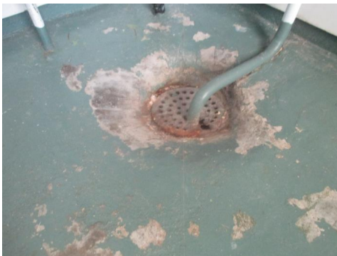
Eldre opprinnelig sluk i gulvet.
