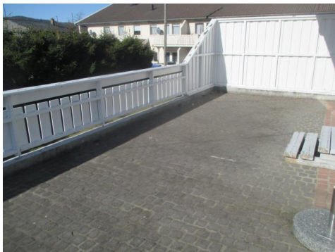
Terrasse over garasje med beleggningsstein.
