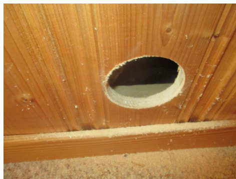
Hulltaking i utfored vegg i kjellerstue.
