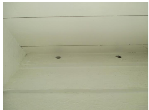
Noen mindre hull ved takutsikk for tilgang på luft.
