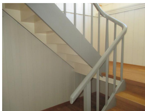
Trapp med tette opptrinn i mellom etasjer
