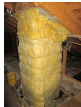
Pipe er blitt isolert bpå kaldtloftet.
