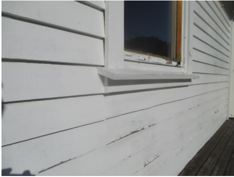
Deler av kledningen med tilhørende belistninger.
