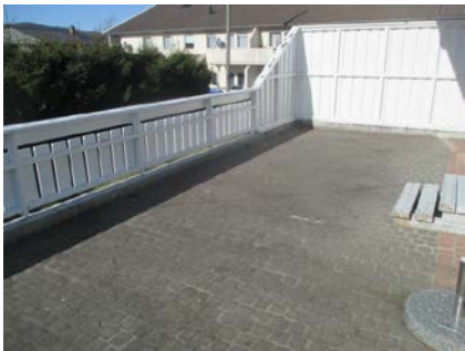
Terrasse over garasje med beleggningsstein.
