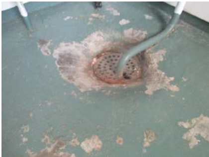
Eldre opprinnelig sluk i gulvet.
