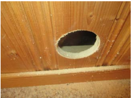
Hulltaking i utfored vegg i kjellerstue.
