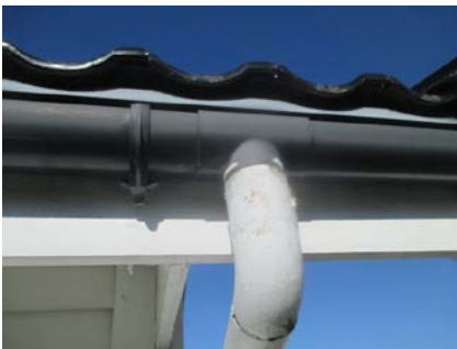
Takrenner og nedløp av plast.
