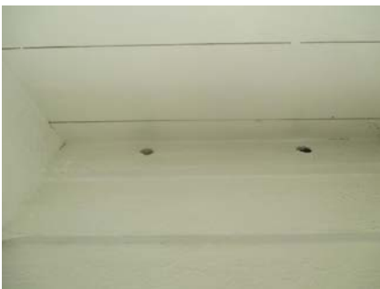
Noen mindre hull ved takutsikk for tilgang på luft.
