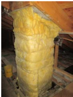
Pipe er blitt isolert bpå kaldtloftet.
