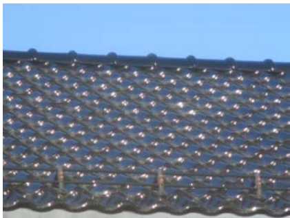
Deler av taktekkingen.
