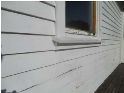
Deler av kledningen med tilhørende belistninger.
