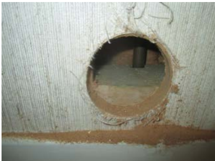
Hulltaking i fra soverom.
