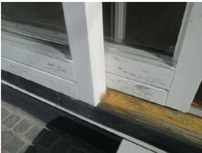
Eldre heve- skyvdør i stue til terrasse.
