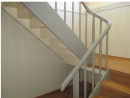
Trapp med tette opptrinn i mellom etasjer
