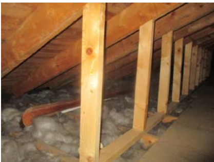
Deler av takkonstruksjonen.
