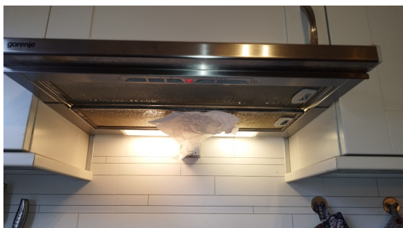
Test av avtrekket.
