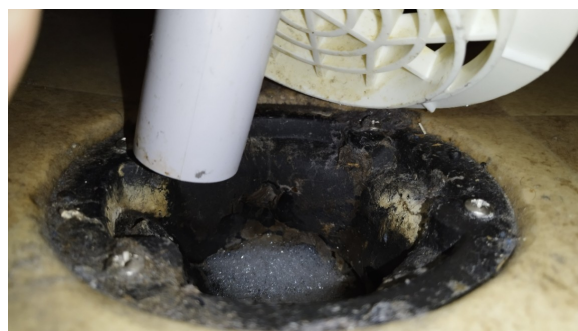
Kontroll av sluken.
