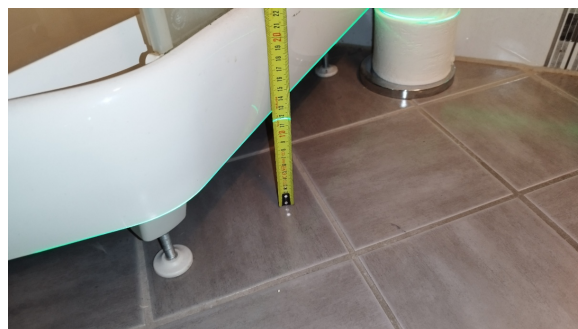
Kontroll av fall.
