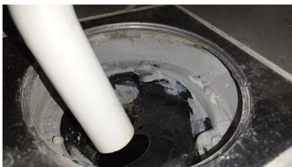
Kontroll av sluken.
