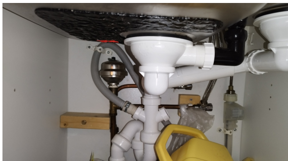
Kontroll av røropplegget.
