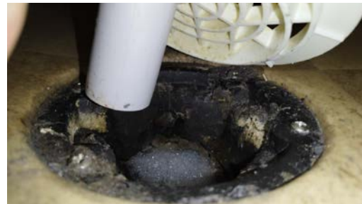
Kontroll av sluken.
