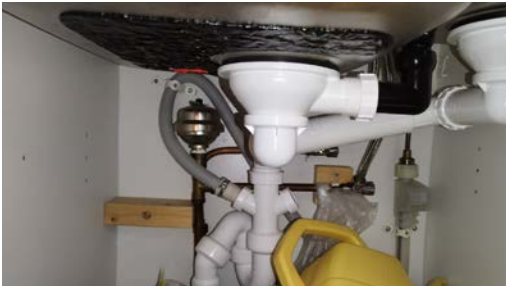
Kontroll av røropplegget.
