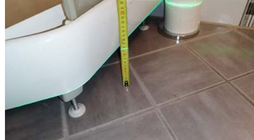
Kontroll av fall.
