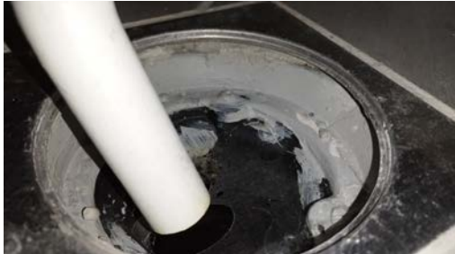
Kontroll av sluken.
