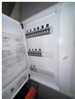
Sikringskap med automatsikringer.
