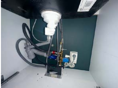
Røropplegg i kjøkkenbenk med Waterguard
