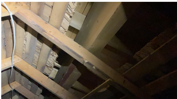
Nye taksperer og nytt undertak lagt over eksisterende takkonstruksjon
