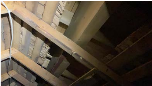
Nye taksperrer og nytt undertak lagt over eksisterende takkonstruksjon
