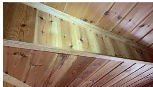
Fuktmerker i overgang mellom gammel og ny hyttedel. Merker var tørre ved befaring.
