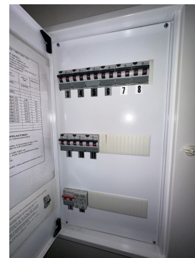
Sikringsskap med automatsikringer.
