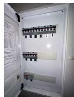
Sikringsskap med automatsikringer.
