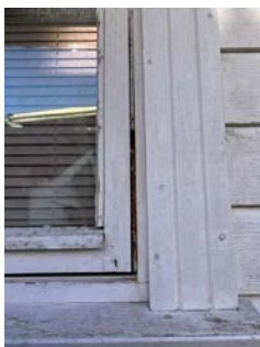
Råteskader i vinduer og glasslister.
