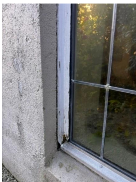
Råteskader i vinduer og glasslister.
