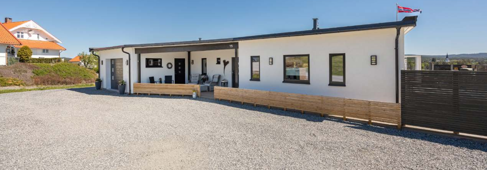
Det er parkering i en integrert garasje og på en stor, gruslagt gårdsplass.
