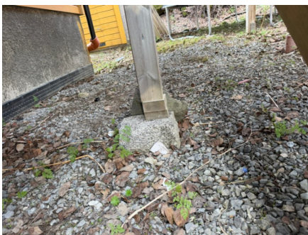
Eksempel på opplagring av søyle.
