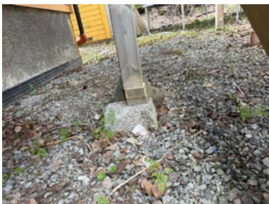
Eksempel på opplagring av søyle.
