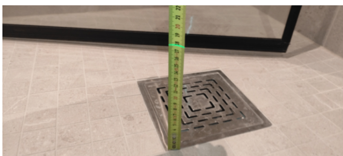
Kontroll av fall mot sluk.
