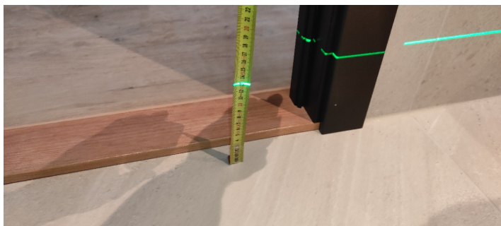
Kontroll av fall mot sluk.
