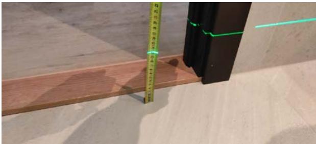
Kontroll av fall mot sluk.
