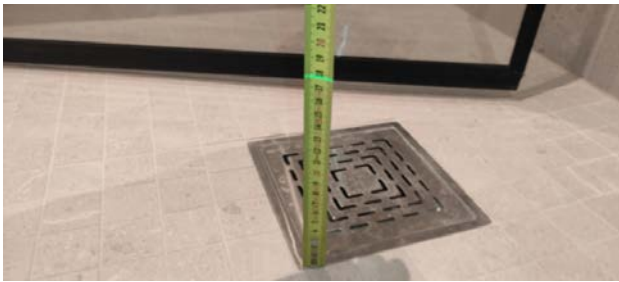
Kontroll av fall mot sluk.
