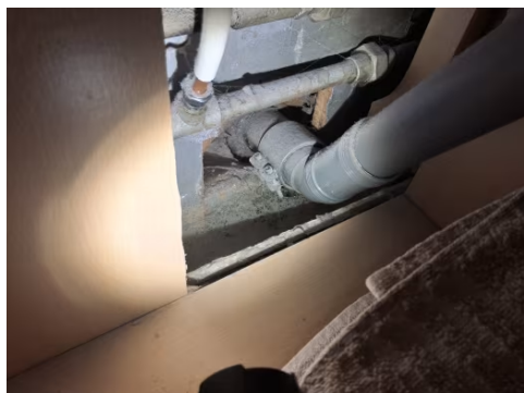
Åpninger i vegg bak servant.
