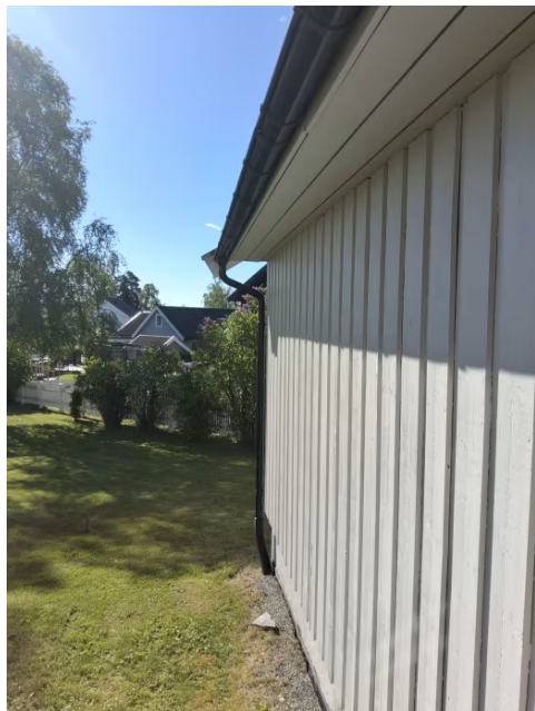
Bygget har takrenner og nedløpsrør i metall.
