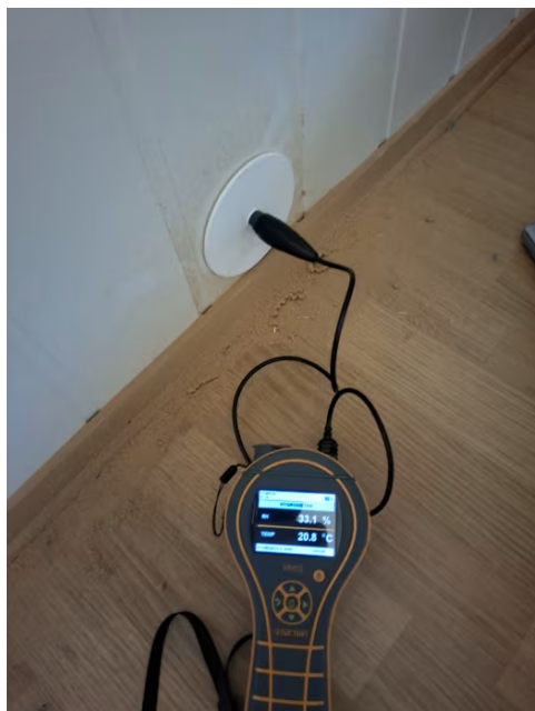
Bilde fra fuktmåling i veggkonstruksjon tilstøtende bad.
