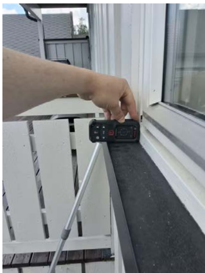
Vannbrett med motfall..
