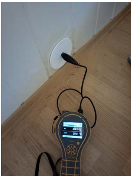
Bilde fra fuktmåling i veggkonstruksjon tilstøtende bad.
