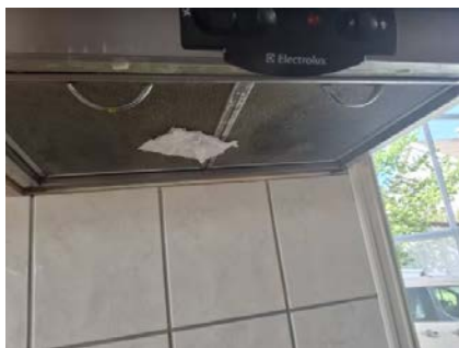
Avtrekkseffekten er testet med papir.
