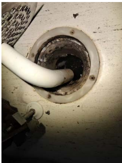
Bilde av sluk.
