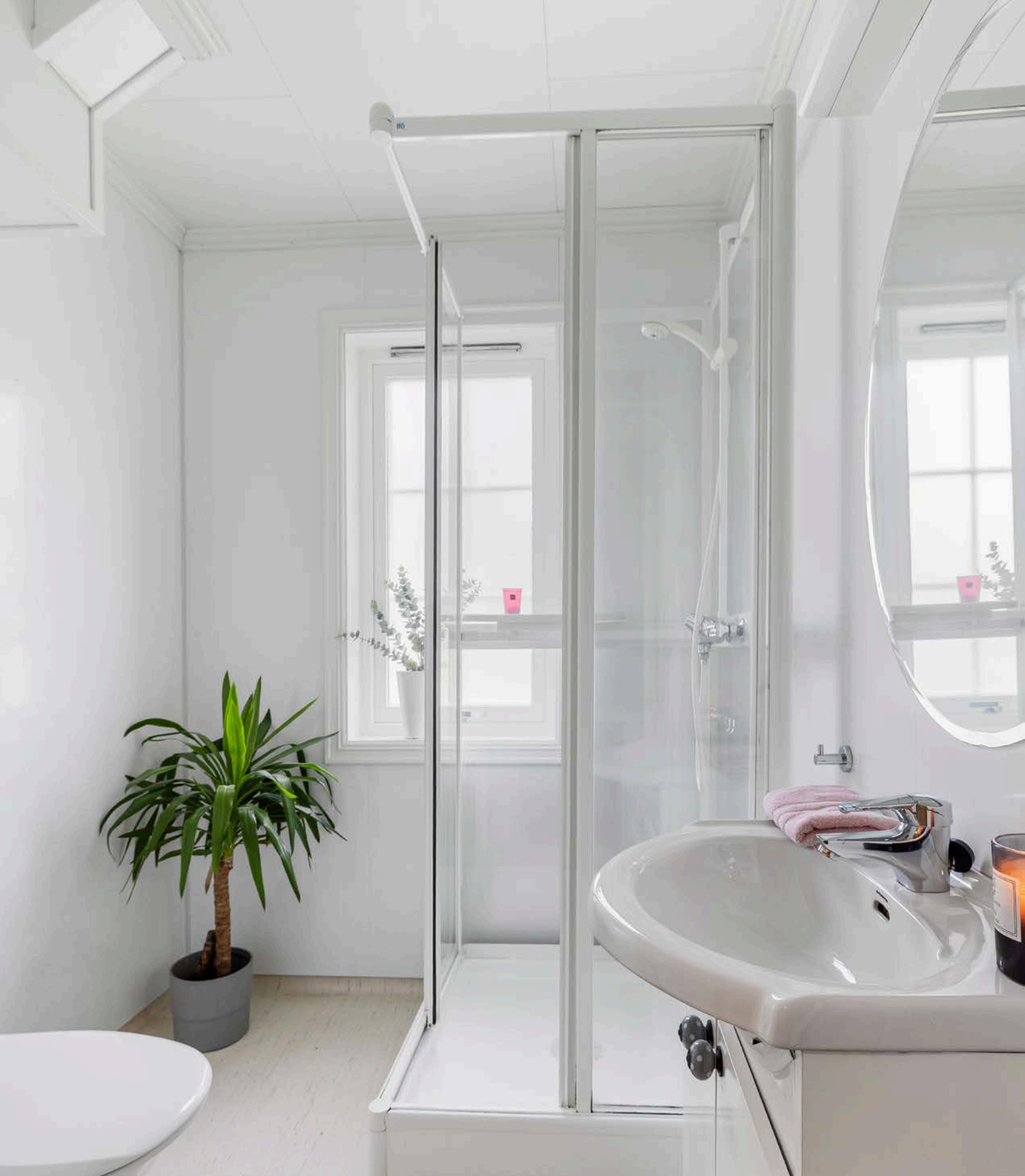
Lyst baderom i 1. etasje med belegg på gulv og våtromsplater på veggene. Badet er utstyrt med servantskap, speil med belysning over, dusjkabinett og gulvstående toalett.
