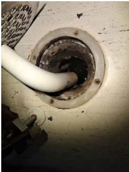
Bilde av sluk.
