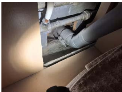
Åpninger i vegg bak servant.
