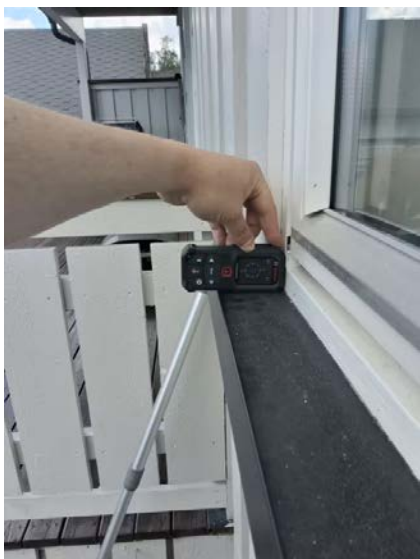
Vannbrett med motfall..
