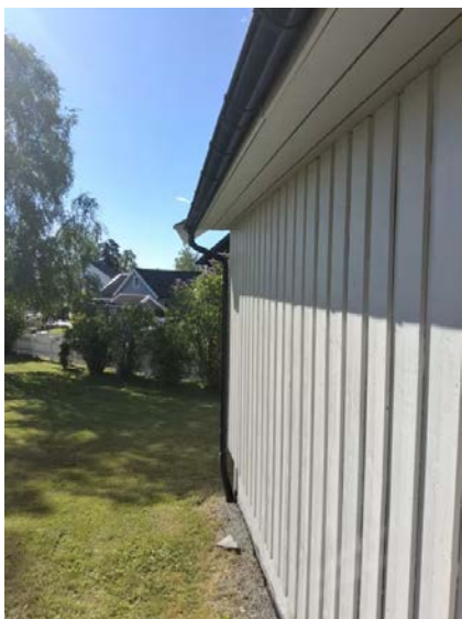
Bygget har takrenner og nedløpsrør i metall.
