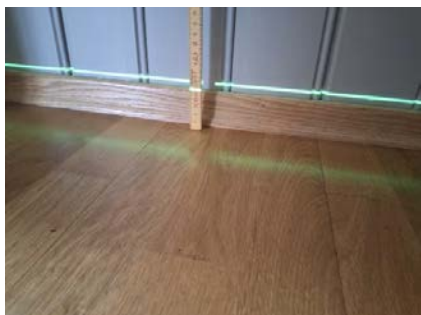
Etasjeskiller ble kontrollert med nivelleringslaser.
