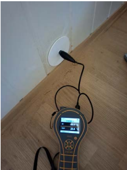
Bilde fra fuktmåling i veggkonstruksjon tilstøtende bad.
