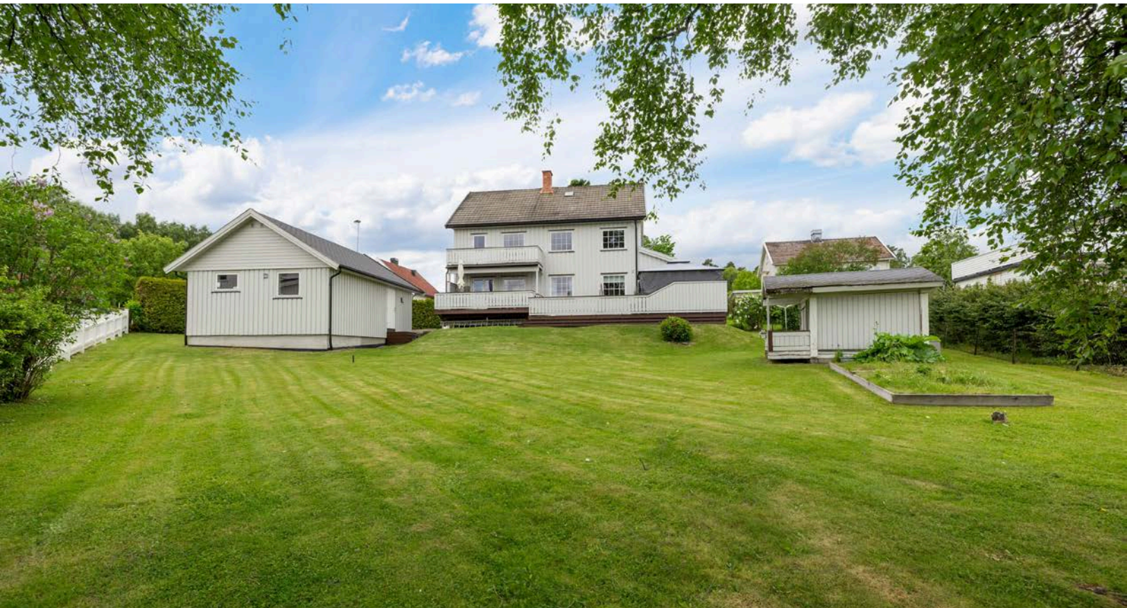
Fra terrassen er det videre adkomst tik den store fine hagen.
