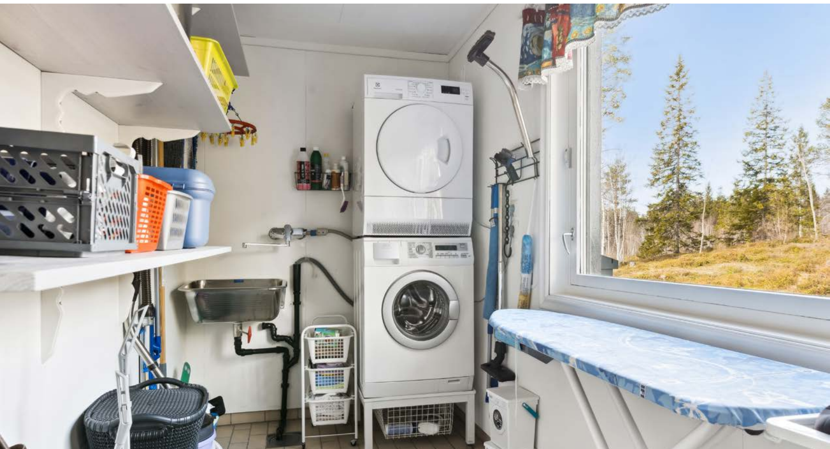
Vaskerom med ytterdør skiftet i 2022. Det er foretatt hulltaking med 73 mm hullbor fra tilstøtende gang. Undersøkelsen viser ingen tegn til skader eller fukt i konstruksjonen.
