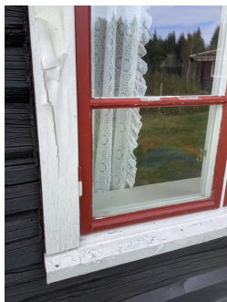
Eksempel på slitasje på omramming.
