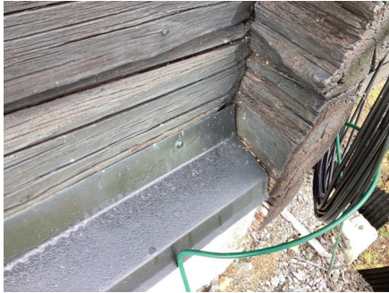
Det er utette overganger mellom beslag og tømmer.
