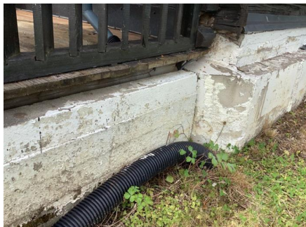
Noe skjevhet på grunnmur på enden.
