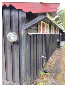
Mulig innkasset nedløp. Mosevekst på innkassing.
