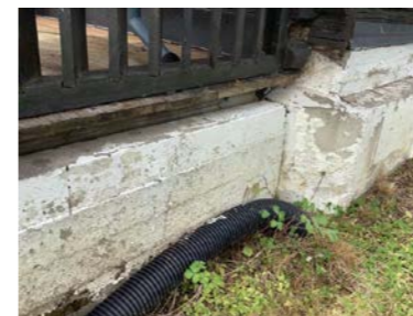
Noe skjevhet på grunnmur på enden.
