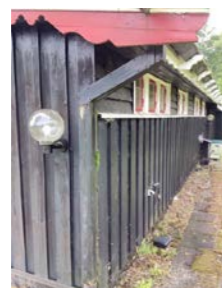
Mulig innkasset nedløp. Mosevekst på innkassing.
