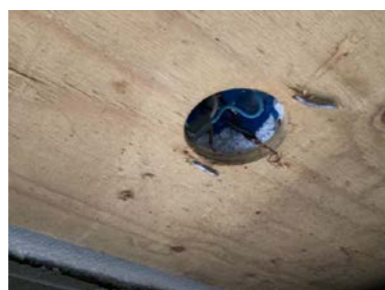
Utsparinger med tvinnende skjøter i kjellerrom.
