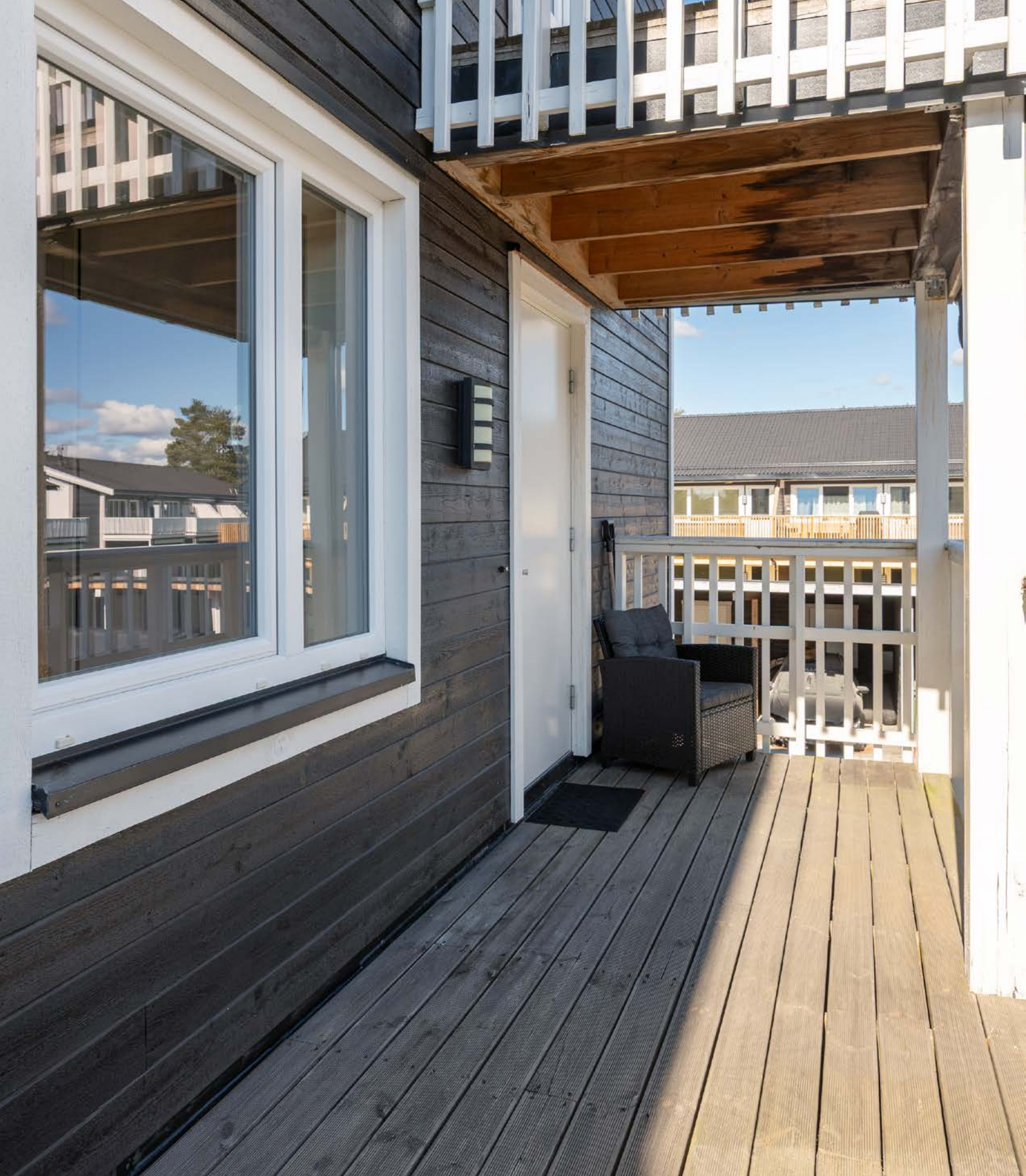
Selve inngangspartiet er overbygd, og det er montert utebelysning ved inngangsdøren.
