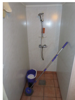
Dusjnise med lokalt fall til sluk.
