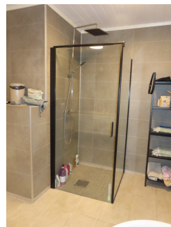
Dusjnise med glassvegg og slagdør. Nye plater på vegg/baderomsplater på vegger i dusjnisen er montert nye i oktober 2025.
